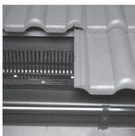
Ochranná mriežka zabraňuje vlietaniu vtákov do medzery medzi odkvapovou latou a profilovanými strešnými škridlami. Vetrací pás zabraňuje vlietaniu vtákov do odvetrávacej medzery vetraného strešného plášťa a do rôznych napojení. Používa sa tak pri profilovaných, ako aj pri plochých strešných škridlach. Oproti jednoduchším verziám Štandard majú navyše robustnejšie telo a kvalitnejší materiál.
