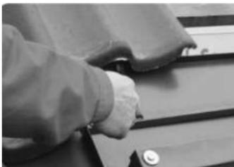
Zrezávanie horného krytia nie je potrebné, ak sa namontuje doplnková strešná lata podľa obr. Montáž upevňovacích lát
