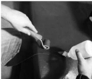
Poznámka - pred inštaláciou odporúčame vykonať zvar na skúšobnej vzorke. Prípadné pretečené miesta utrieme handrou a vyhneme sa šlapnutiu až do úplného stuhnutia prípravku. Je potrebné tiež zabrániť kontaktu s polystyrénom, pretože v kontakte s THF môže dôjsť k jeho poškodeniu.
